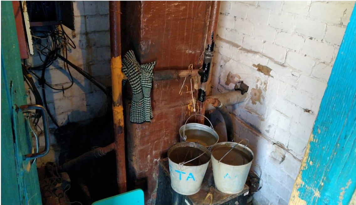
Рис.1 Состояние объекта «До».
